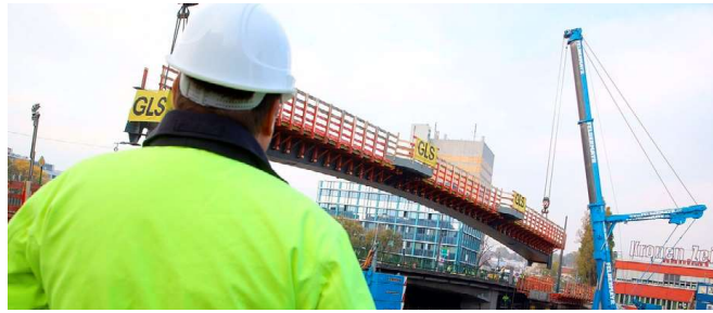
Parallel zur Heiligenstädter Brücke hat man ein weiteres Tragwerk für eine 94 Meter lange Brücke aufgesetzt. Foto: PID/Votava
